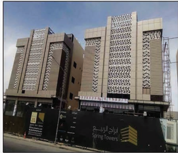
Al Rabeaa Towers
